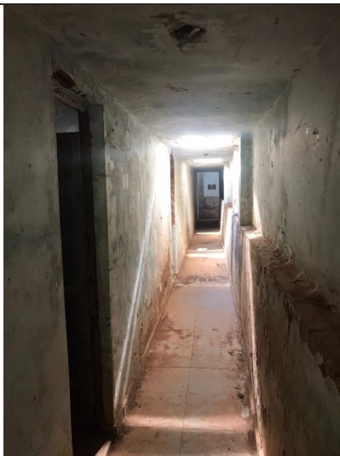
Descrição: CORREDOR BANHEIROS
