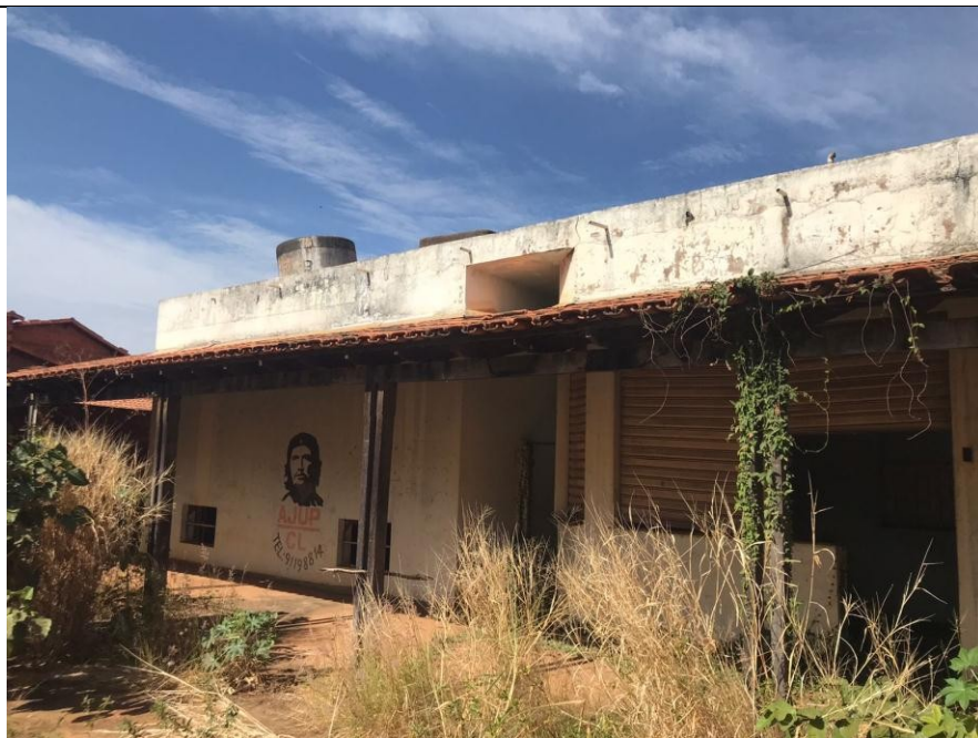
Descrição: VISTA POSTERIOR DA EDIFICAÇÃO
