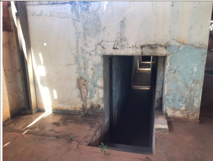
Descrição: VISTA DO ACESSO AOS BANHEIROS
